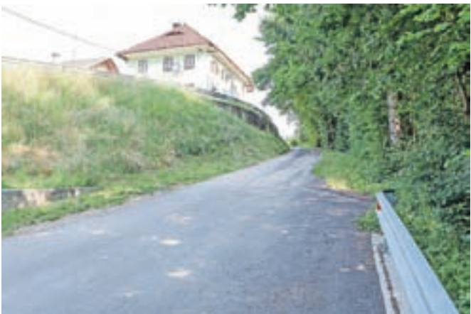
Izvajalec skorajšnje sanacije ceste v Zadrage je Gorenjska gradbena družba. Investicija je vredna okrog sto tisoč evrov. To bo zahteven poseg z izgradnjo vodovoda, kanalizacijskega voda, razširitvijo vozišča in ureditvijo podpornega zidu. / FOTO: TINA DOKL
