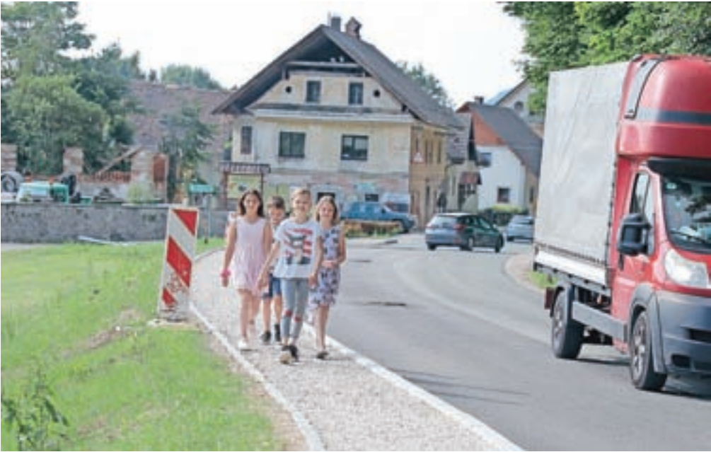
Največji letošnji projekt v občini, vreden blizu sedemsto tisoč evrov, je gradnja kanalizacije v Podbrezjah sočasno z rekonstrukcijo ceste in ureditvijo varne poti v šolo. Vodja Podružnične šole Podbrezje Mateja Jarc je povedala, da so zelo veseli pločnika. Da je pot zdaj varnejša, so povedali učenci Ažbe, Katrina, Hana in Ana (na sliki). / FOTO: TINA DOKL
