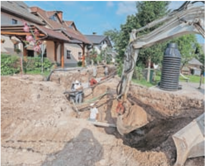
Na Okroglem zasebni investitor menja srednjenapetostni kablovod, občina pa obnavlja kanalizacijo, vodovod, elektriko, javno razsvetlavo, odvodnjavanje meteornih voda in komunikacijske vode. Gradnja bo zaključena sredi julija, še letos bo občina nadaljevala gradnjo pločnika in fekalnega kanala ob Dinosu proti Okroglemu. / FOTO: TINA DOKL
